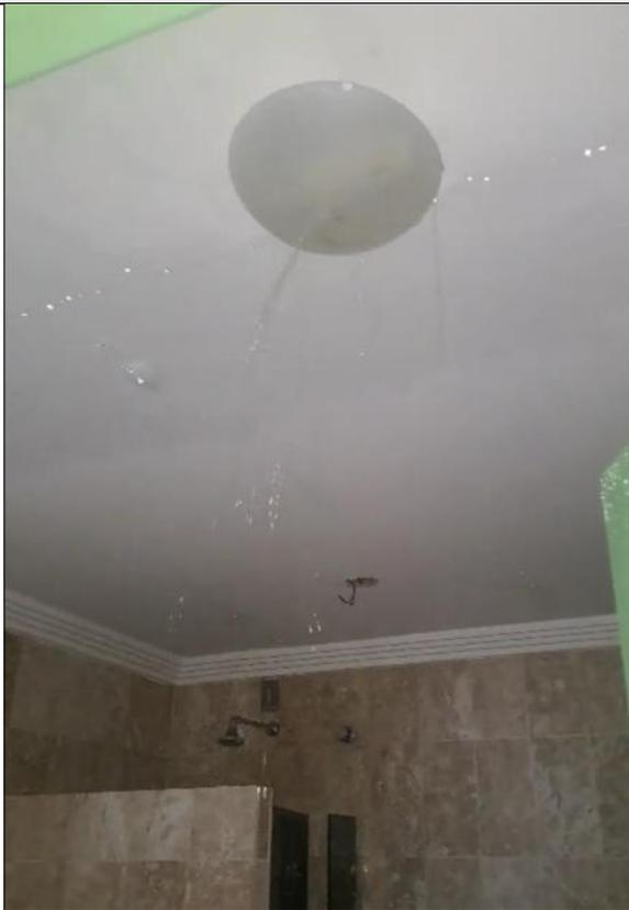
*Vazamento no teto pelo sistema de iluminação*
